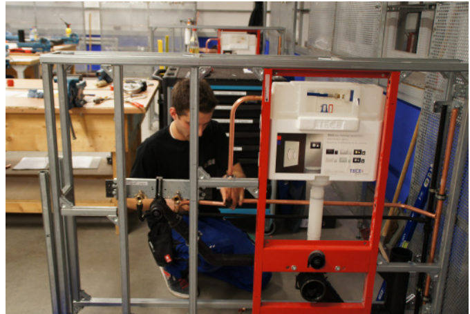
Matthias Köfer bei der Vorwandinstallation
